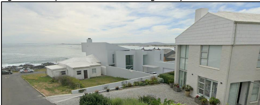
Figuur 8: Dakprofiel versteur die matige daklyn
